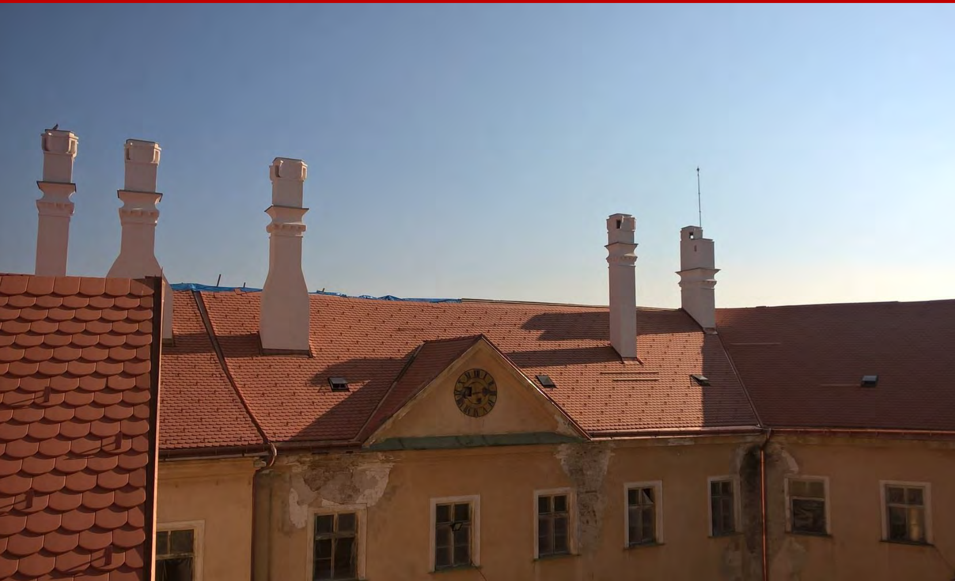
Rekonštrukcia zámku _ strecha
